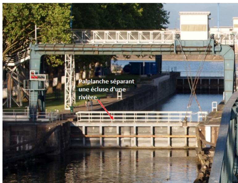
Figure 4.27: Un rideau de palplanche long 100m séparant une écluse d'une rivière
